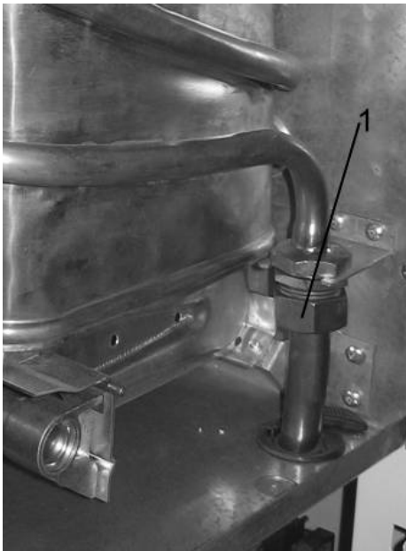
Рис. 20. Демонтаж трубы насоса
