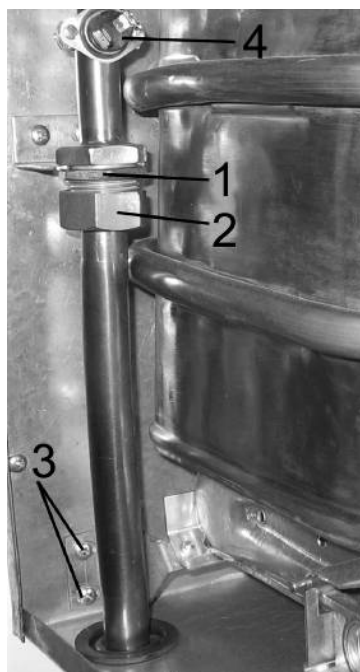
Рис. 18. Демонтаж горелки
