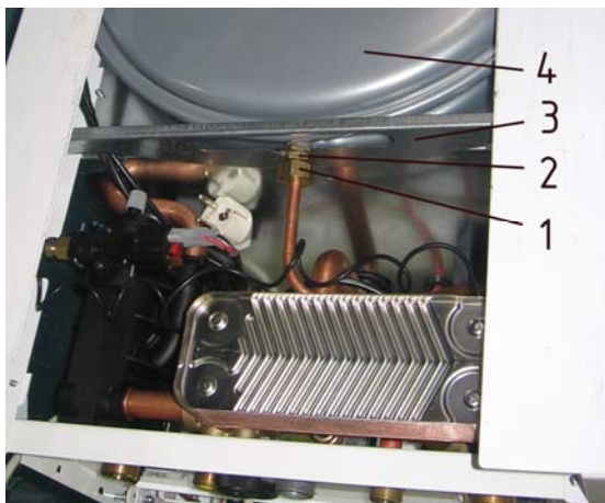
Рис. 25. Демонтаж трубы расширительного бака
