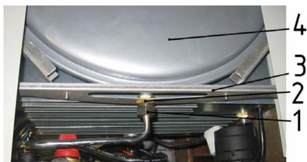
Рис. 16. Демонтаж трубы расширительного бака
