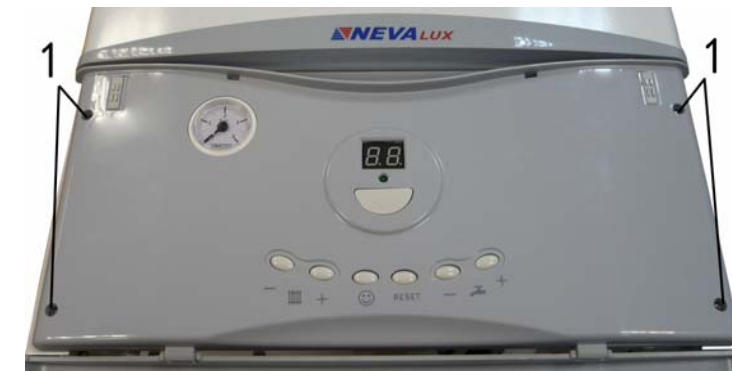
Рис. 7. Демонтаж облицовки и панели управления
